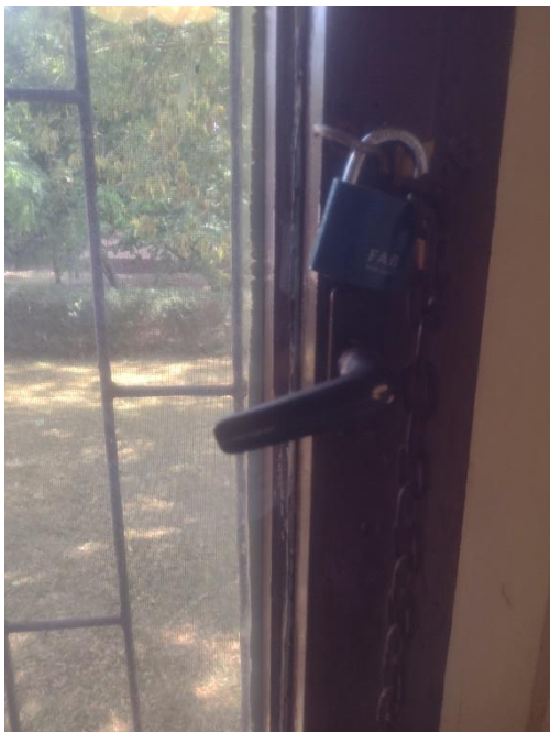
Zabezpečenie okna jednej z liečebných izieb
