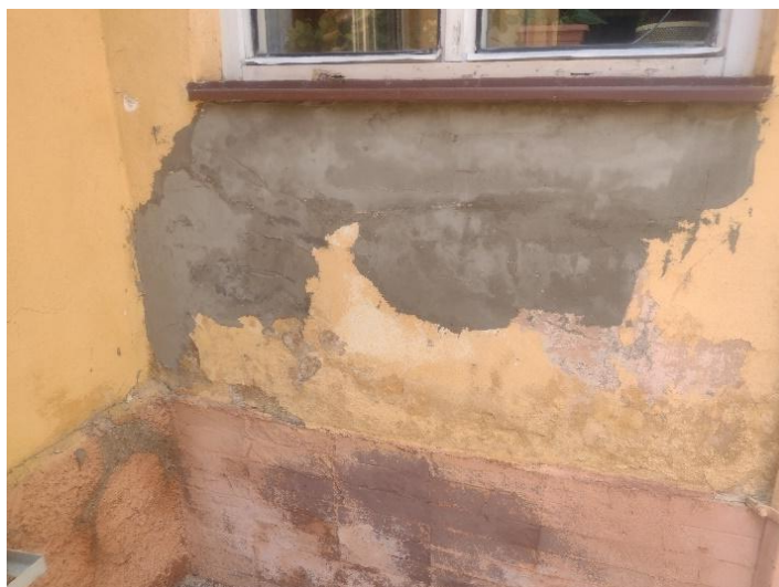
PL Plešivec - vonkajšie stena jednej z budov liečebne
